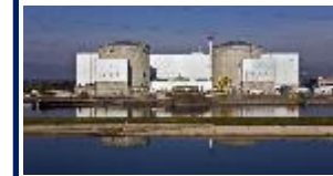
Fessenheim Réacteur à eau pressurisée 1978-2020 Décret démantèlement : prévu début 2026
