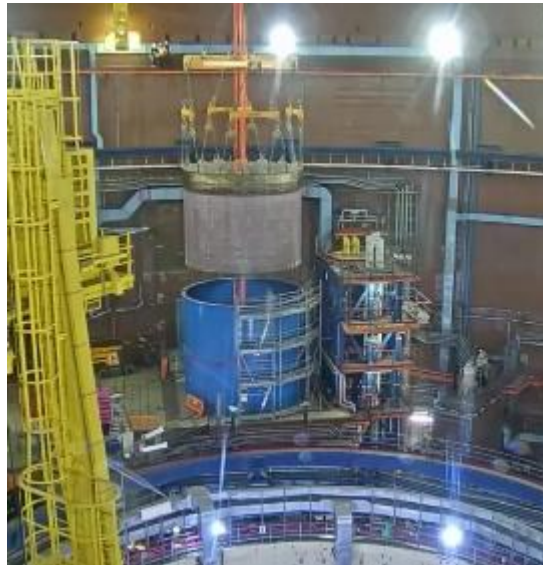
Levage du petit bouchon tournant de Superphénix (212 T)
