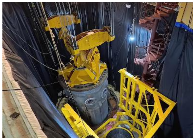
Levage de la cuve de Chooz A (190 T)
