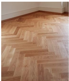
Remise en état
