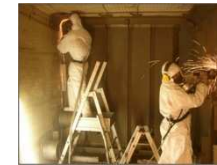
Démantèlements d'installations anciennes
