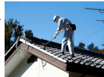
Brossage de tuiles d'un toit
