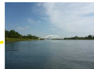
VUE DE LA PARTIE AVAL DE LA STATION ES7
