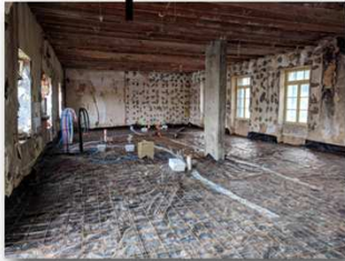
Mars 2020 Membrane pare-radon Coulage des dalles
