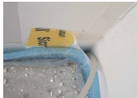
Vide derrière couche de désolidarisation du plancher chauffant
