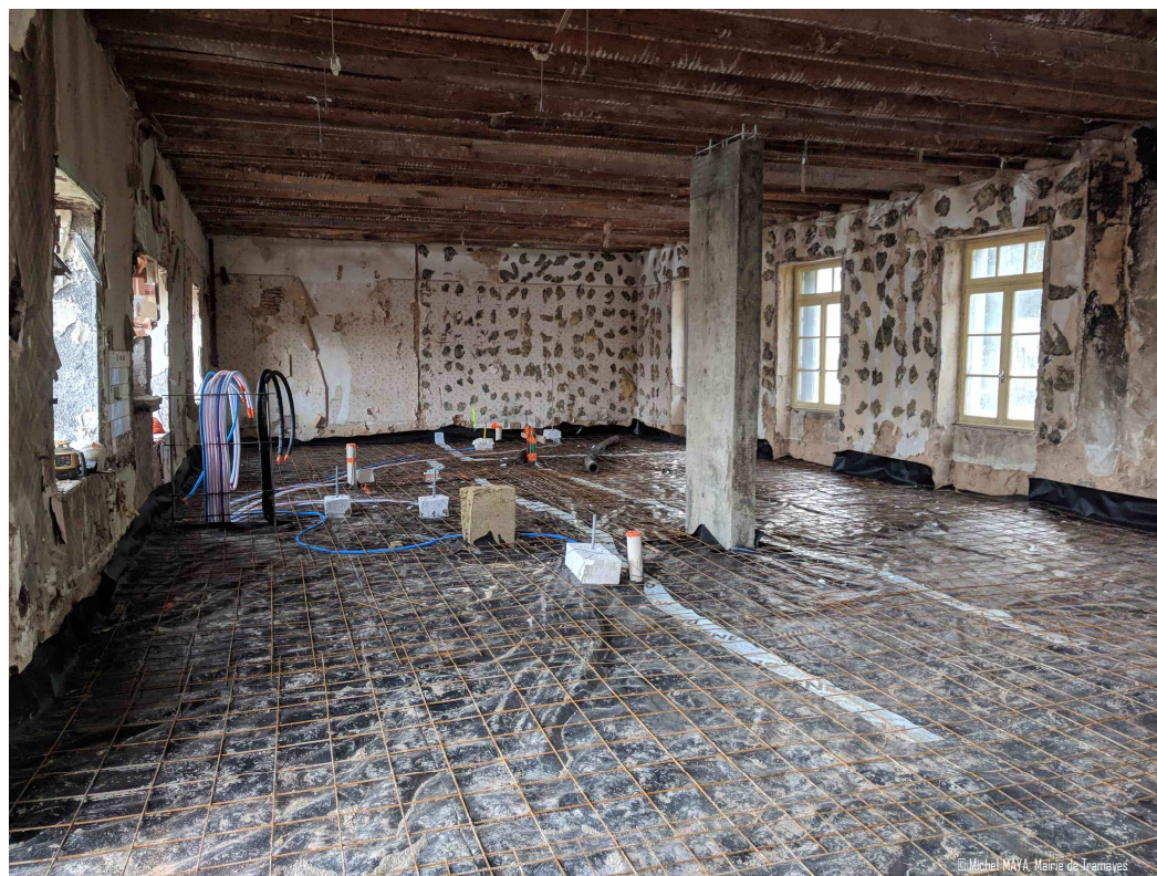
Membrane pare-radon avant coulage de la dalle, 4 mars 2020
