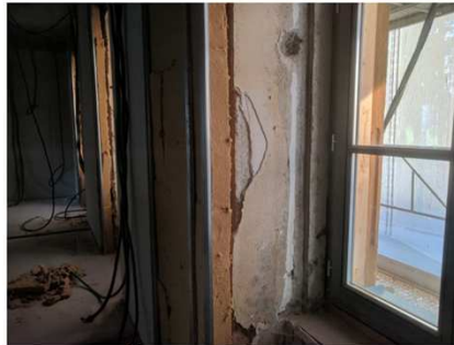
Novembre 2020 Isolation extérieure et intérieure
