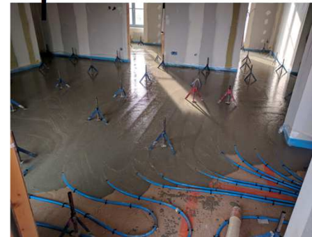
Février 2021 Chauffage au sol
