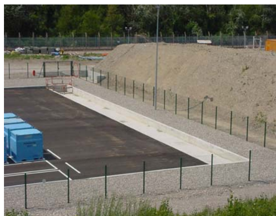
Aire d'entreposage de Fessenheim (vue générale et fosse de récupération de la zone huiles)
