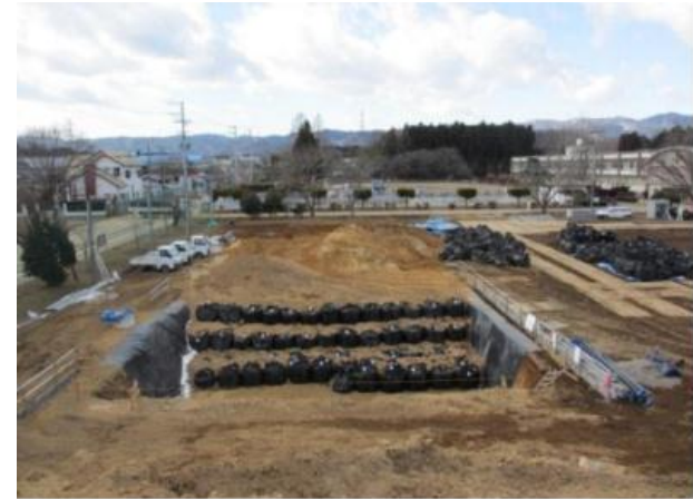
Mise en place de sites d'entreposage en l'attente de la définition et de la mise en œuvre d'un site de stockage
