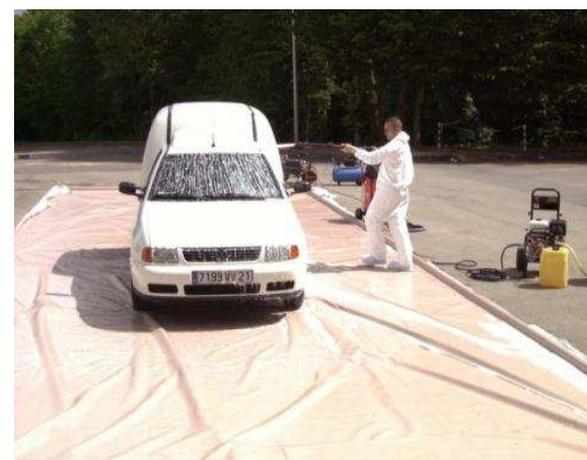
Décontamination véhicule et récupération des effluents
