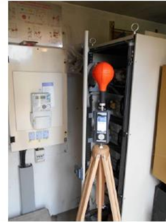
Photo n°1B Armoire condensateurs SOCOMEC (devant l'armoire)
