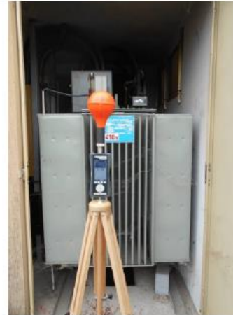
Photo n°1D Transformateur HT/BT AREVA 1250 KVA 1760A devant le transformateur
