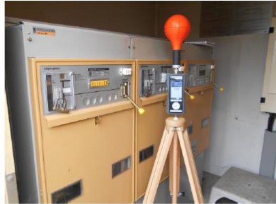
Photo n°1A Cellules Haute Tension 20 KV TGBT 4X2500A (devant les cellules)
