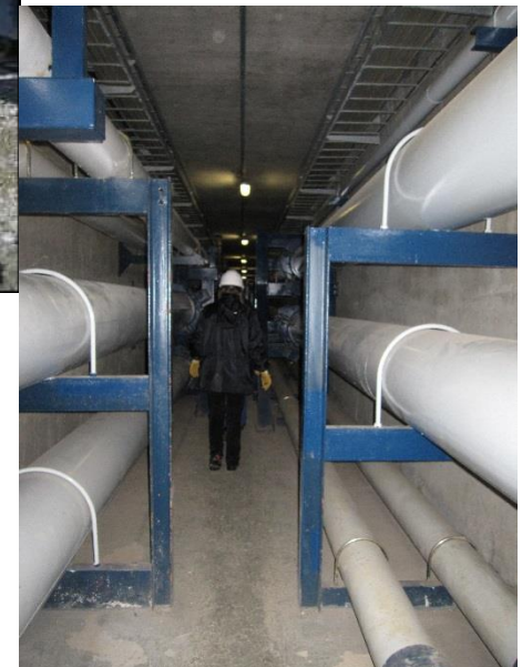
Galerie technique enterrée
