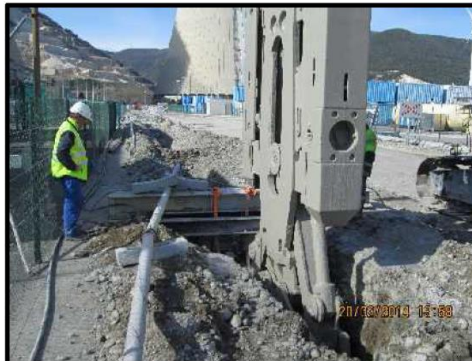
Réalisation d'une enceinte géotechnique
