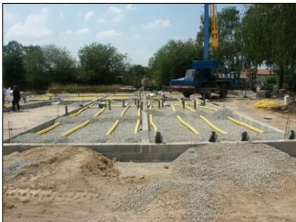
Bâtiment construit en Haute-Vienne sur terre plein avec SDS + mise en place d'un système de ventilation double flux
