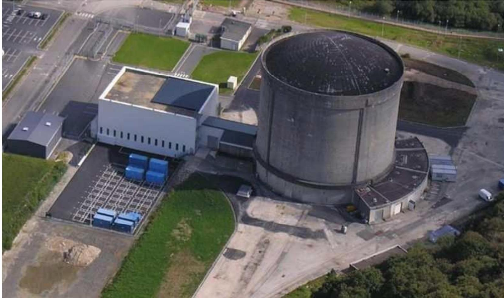
**BRENNILIS:** Prototype industriel de réacteur modéré à l'eau lourde, refroidi au CO<sub>2</sub>, uranium faiblement enrichi (70 MWe)
