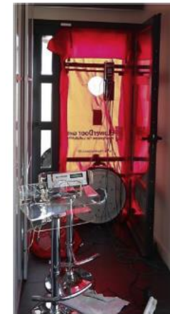
Mesure de perméabilité à l'air
