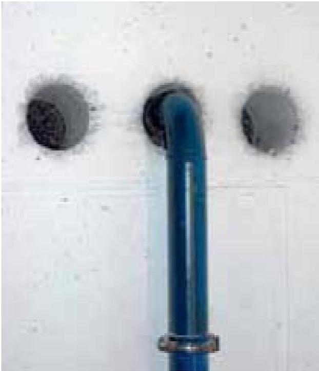
Les ouvertures et les fissures importantes dans les parties du bâtiment en contact avec le terrain doivent être obturées.
