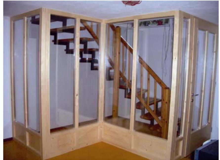
Renforcement de l'étanchéité de la descente vers la cave, à l'aide d'un habillage étanche à l'air (avant et après).
