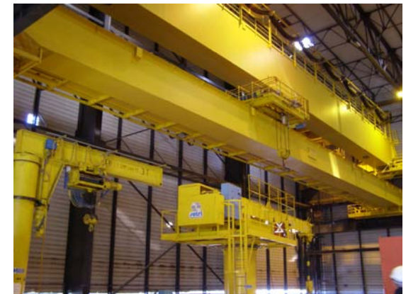
CNPE de Flamanville Ponts salle des machines
