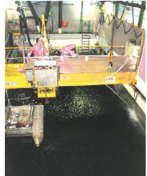
Lançage de jets haute pression sur les parois d'une piscine
