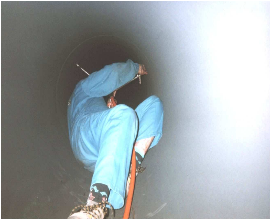
Mise en place du porte source dans une tuyauterie
