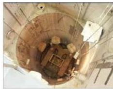
Piscine avant décuvelage
