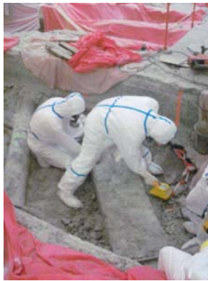
Opération de dégagement et de contrôle des réseaux enterrés
