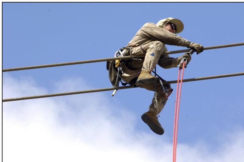
**Figure 1 : situation typique d'exposition au champ magnétique 50 Hz un monteur TST au potentiel**
